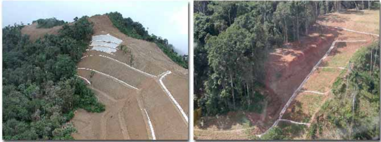
Erosion control devices, and reforestation along the right-of-way, photos © Antonio Salas with Grupo de Especialistas de la Sociedad Civil para el Proyecto de Camisea
